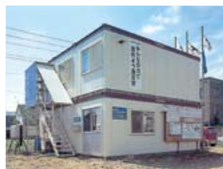
プレハブ建築 工事事務所 (シグマハウス)
